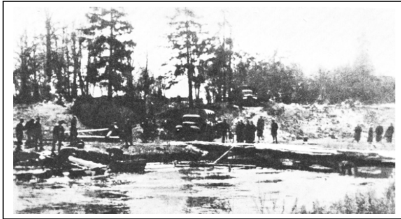
Budowa mostu na rzece przez saperów 10 DP
